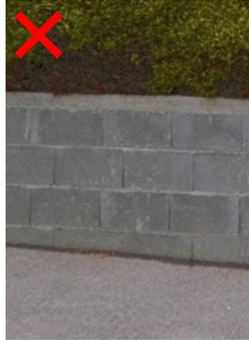
Les murs en parpaings apparents ne doivent rester qu'une solution temporaire; Leur recouvrement par un enduit est nécessaire à court terme. De la même manière, les clôtures bétons "nues" sont à éviter.
