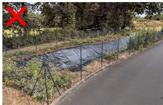
Les bassins d'orage ne doivent être aménagés qu'en dernier recours
