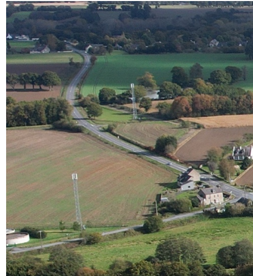
Deux des trois antennes relais de la commune situées vers le carrefour de la butte
