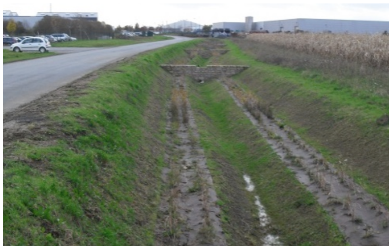
Aménagement des eaux pluviales sur Actipole
