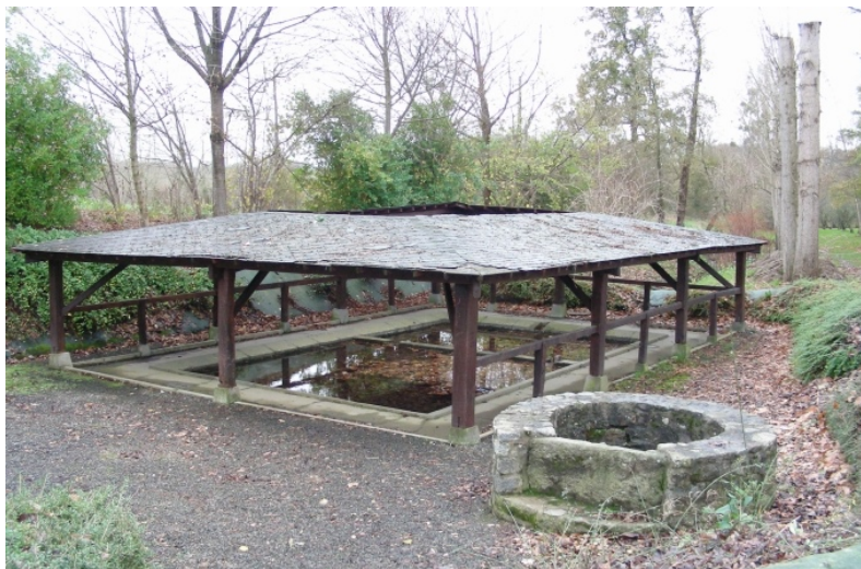
Le lavoir de la rue d'Abas
