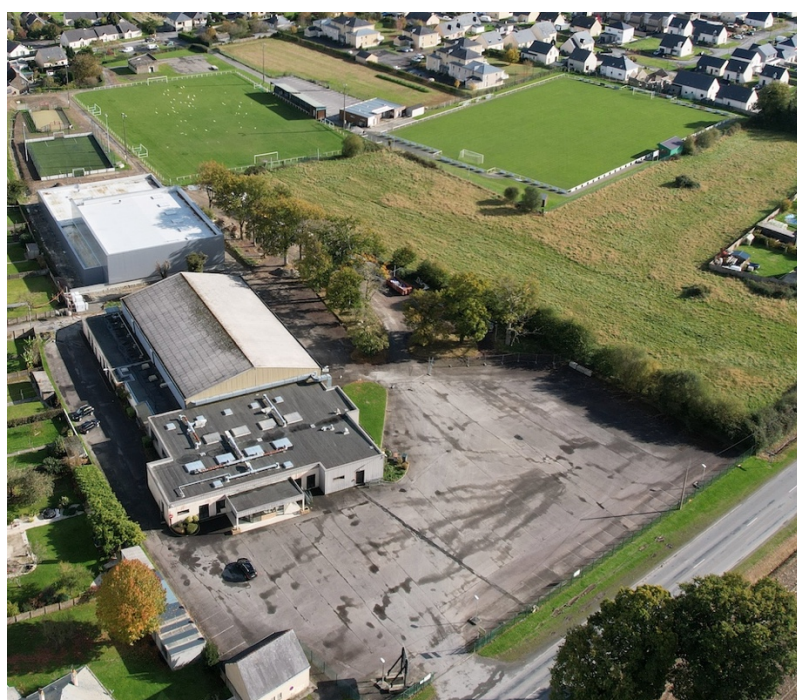
L'espace Bel-Air avec, en arrière-plan, le chantier de la future salle de sport
