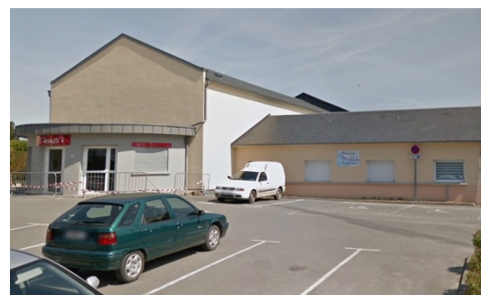
Bâtiment regroupant la salle de spectacle et la maison de l'enfance
