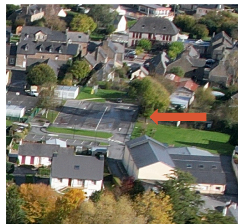
L'espace de stationnement situé entre l'école publique et l'Acousti'k a une capacité d'une cinquantaine de places
