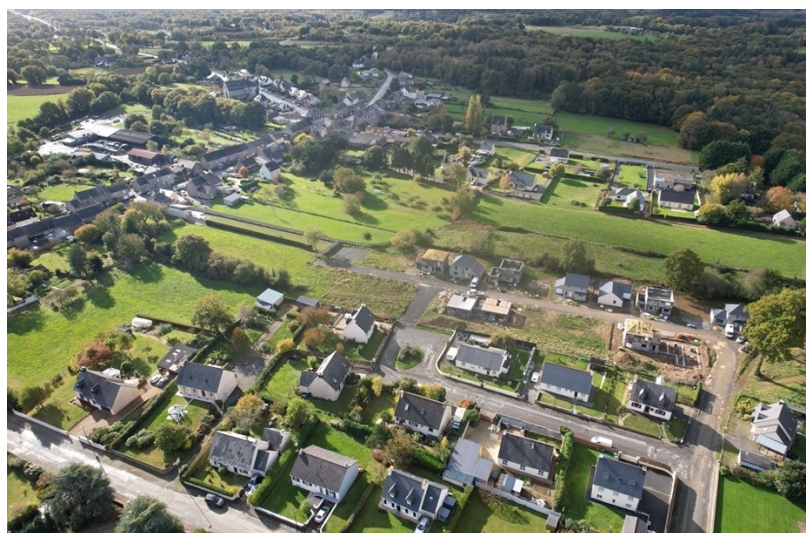
Vue sur un nouveau lotissement en construction au Nord du Vieux-Bourg
