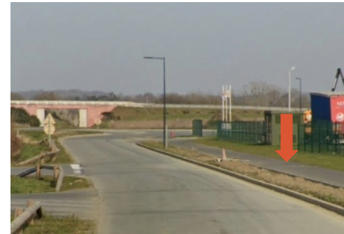
Aménagements cyclables au Nord de la zone Actipole
